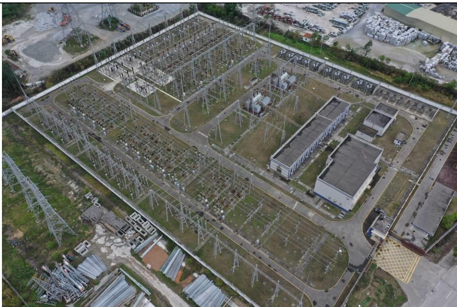
220千伏孟槐站生态恢复情况
