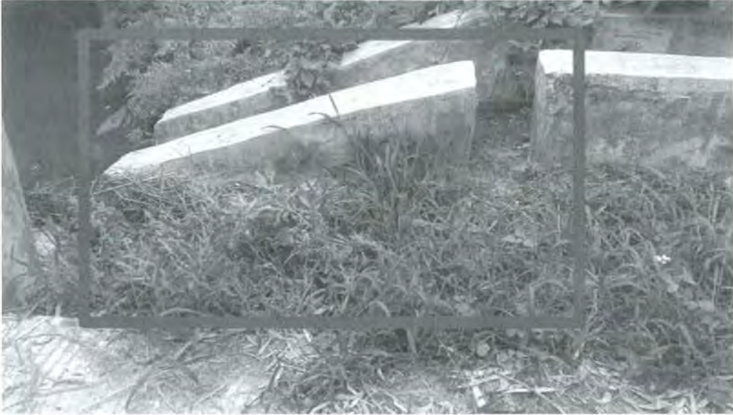
图 5 渠道终点直排河涌
