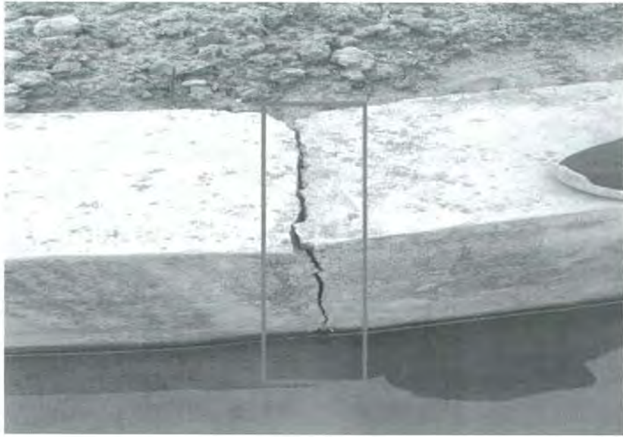
图 11 渠道裂缝
