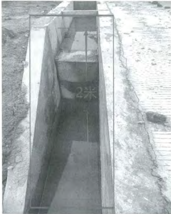
图 23 路面边侧与渠道底部高差约 2 米
