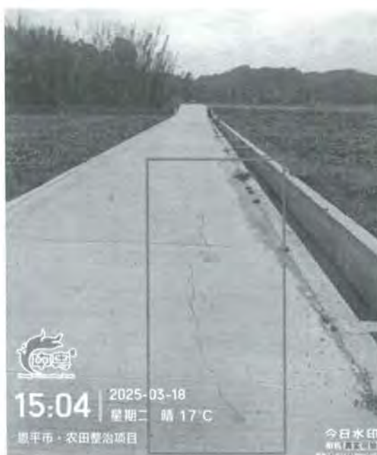
图 18 路面裂缝
