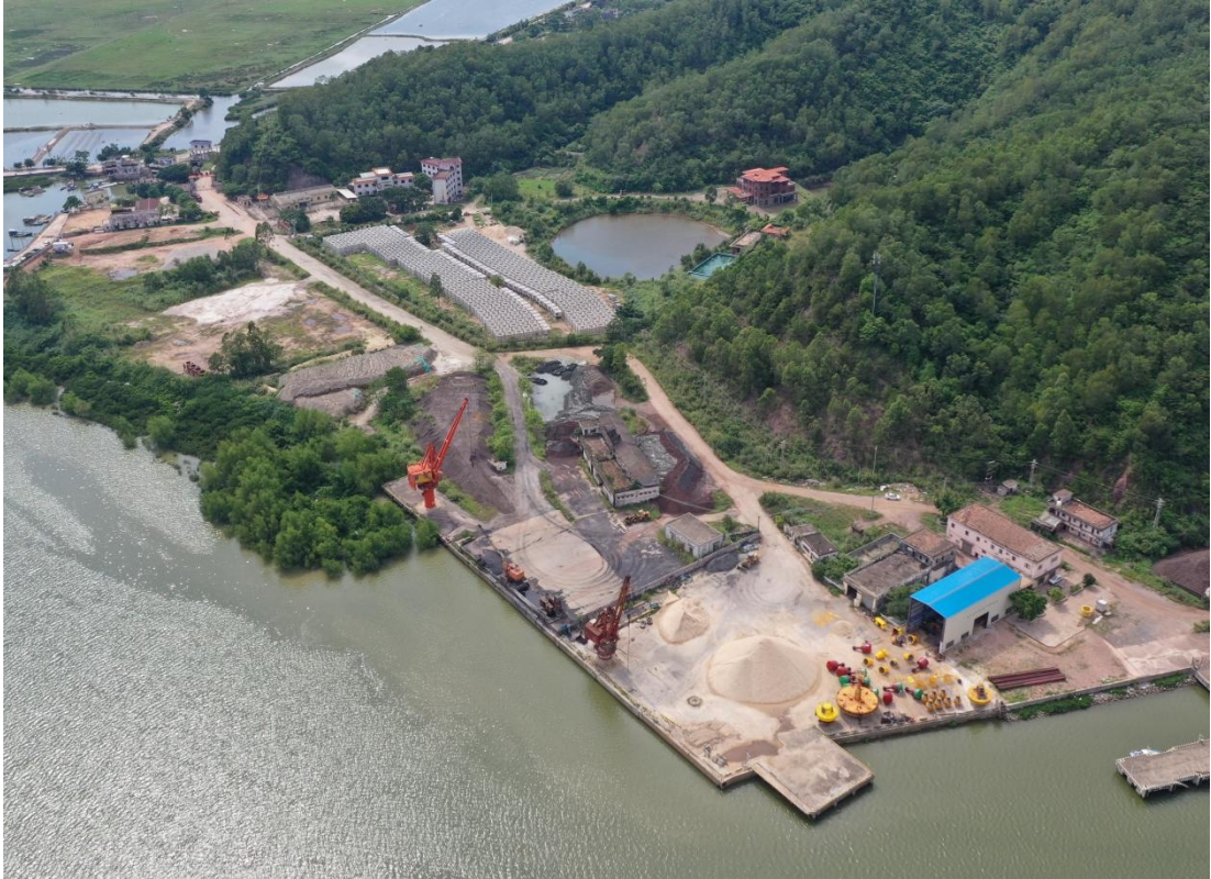
图 2-3 恩平港现场图
