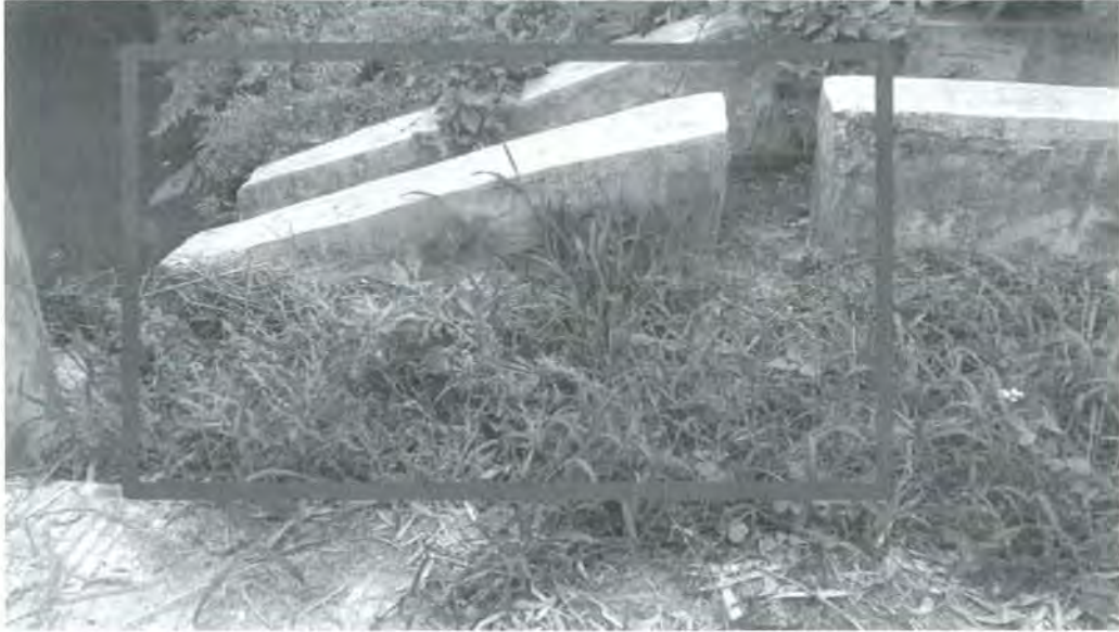
图 5 渠道终点直排河涌
