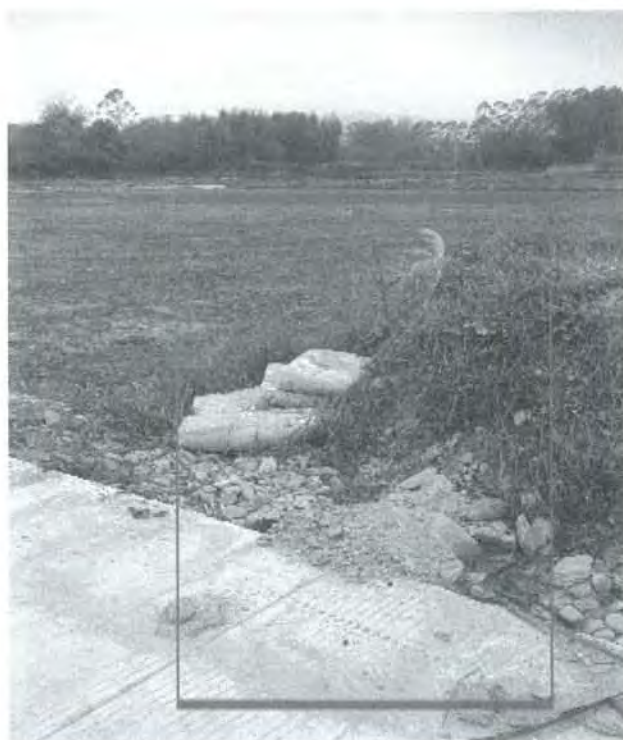
图 16 路边堆弃建筑垃圾未清理
