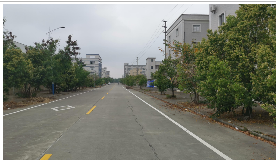
项目东面（工业道路）
