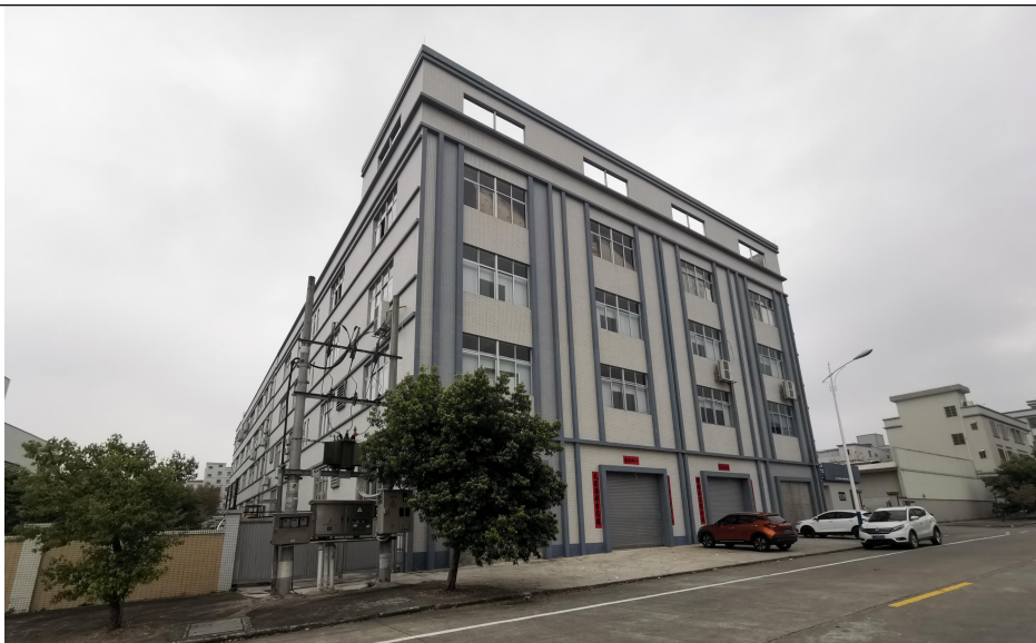
项目北面（工业厂房）
